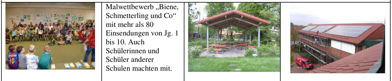
Bild Mitte: Grünes Klassenzimmer mit Schülerhilfe. Die Metall- und Dachkonstruktion errichtete eine Firma Bild rechts: 2011 wurde die Fotovoltaik-Anlage auf der Schule errichtet und läuft seit fast sieben Jahren mit gleicher Leistung und ohne technische Probleme
